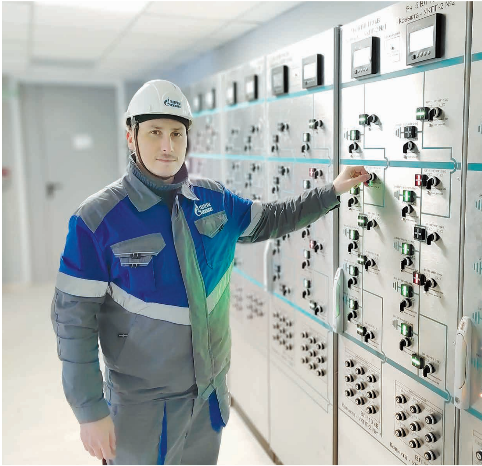
Ведущий инженер Семён Яровиков на ПС-110 УКПГ-2
