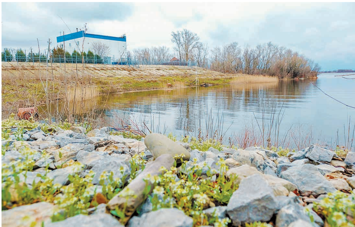
Водозабор на реке Бузан
