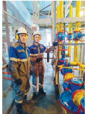
Осмотр технического состояния газорегуляторной установки
