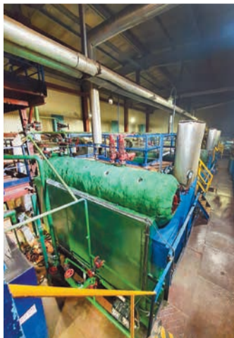
Капитальный ремонт котла 1 ДЕВ-10-14
