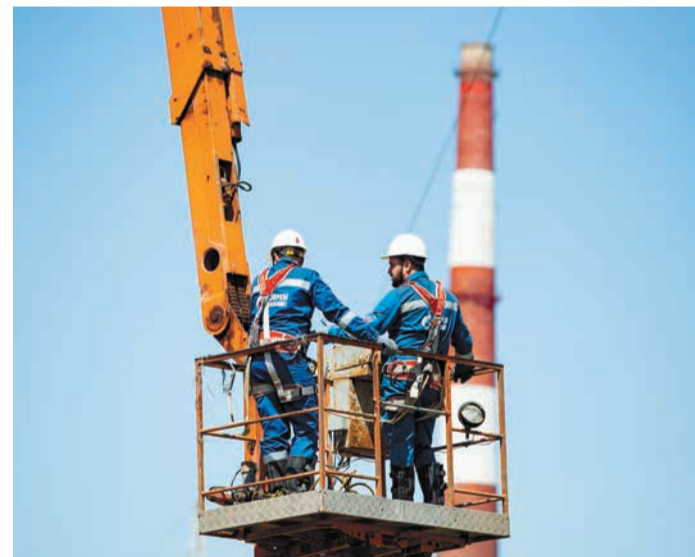
Работы по текущему ремонту ВЛ-110 Каргалинская ТЭЦ – Газзавод-1
