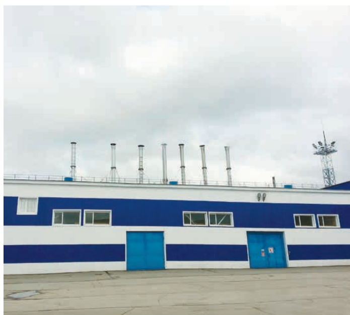
Котельная № 1 участка ЭВС № 1 цеха ЭВС № 2 (город Ухта)
