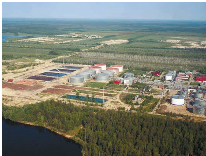
Начало строительства комплекса очистных сооружений
