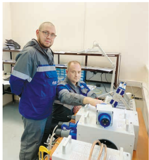
Поверка трансформаторов тока
