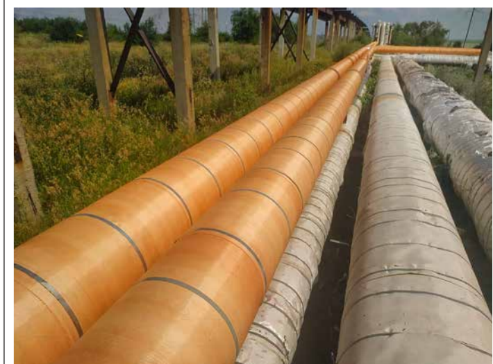
Участки заменённого трубопровода
