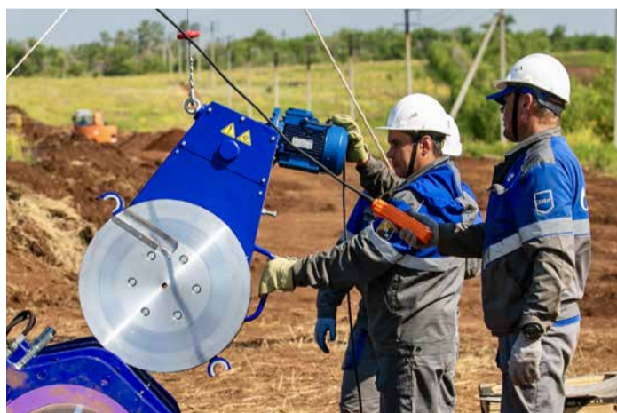
Установка фрезы в станок
