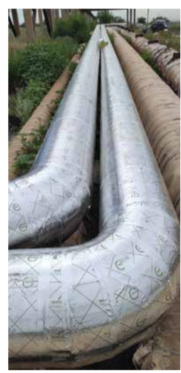
Монтаж современным изолирующим материалом
