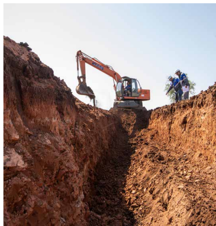
Контроль за разработкой траншеи по глубине
