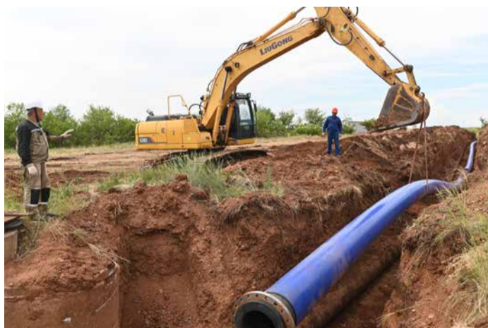
Укладка трубы в траншею бригадой подрядчиков
