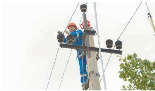
Замена опорного изолятора на ВЛ-10 кВ
