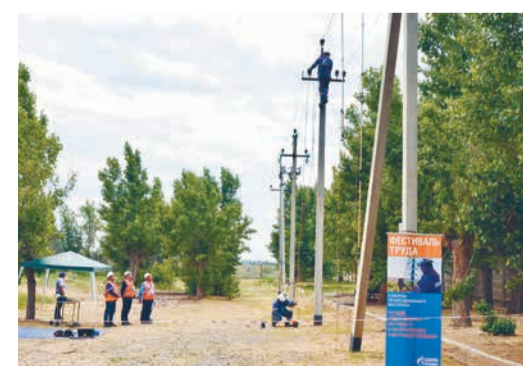
Зона практического задания для электромонтеров
