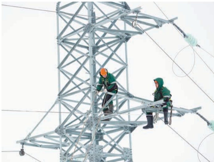
Подготовка такелажных приспособлений перед подъемом проводов
