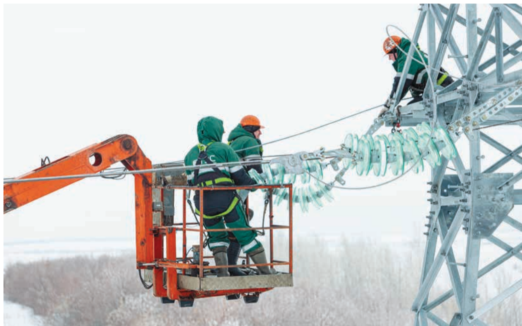
Крепление гирлянды изоляторов
