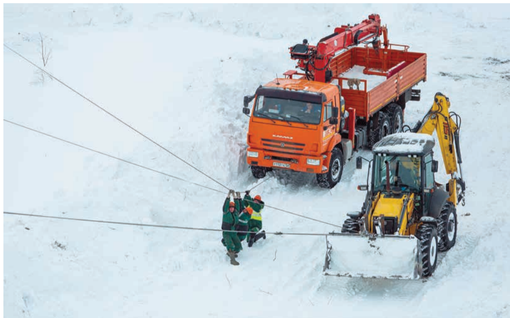
Натяжка проводов при помощи тяговых механизмов
