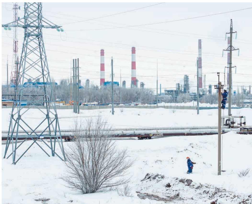
Подготовка рабочего места. Установка переносного заземления на пересекаемую ВЛ-6 кВ
