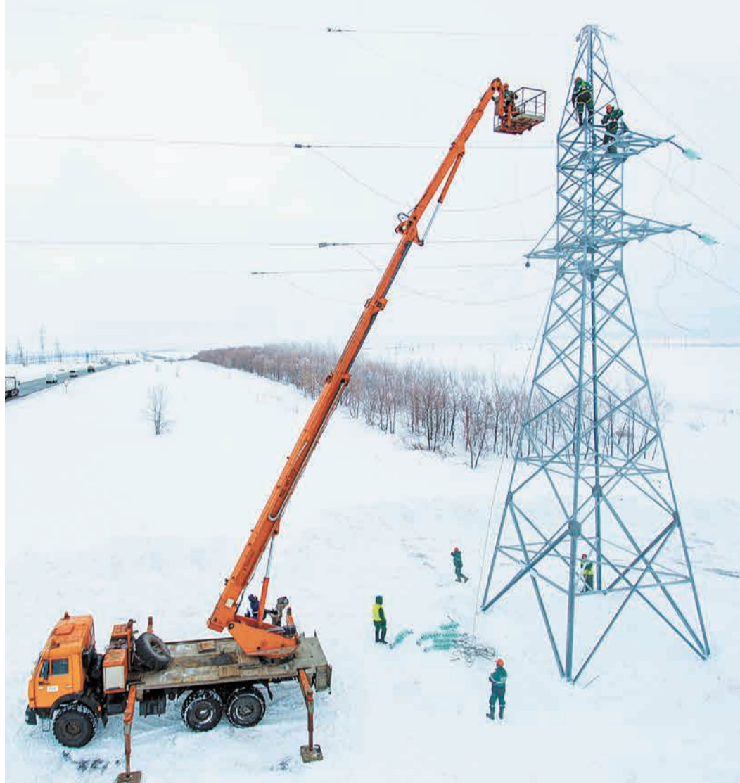
Крепление гирлянды изоляторов
