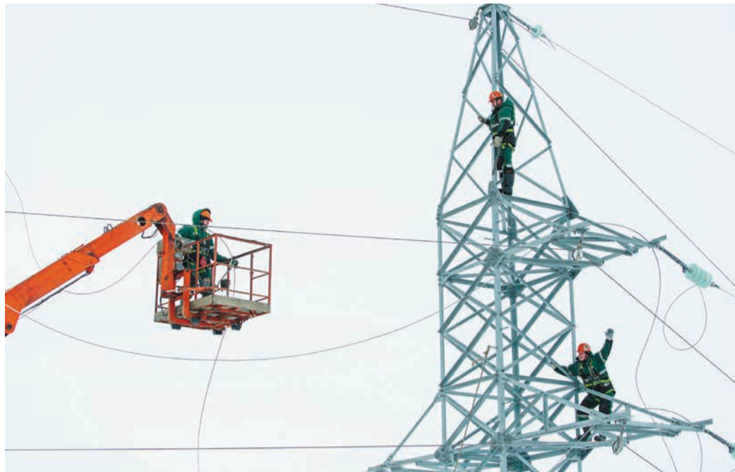
Натяжка проводов. Регулировка стрел провеса проводов в процессе их натяжки
