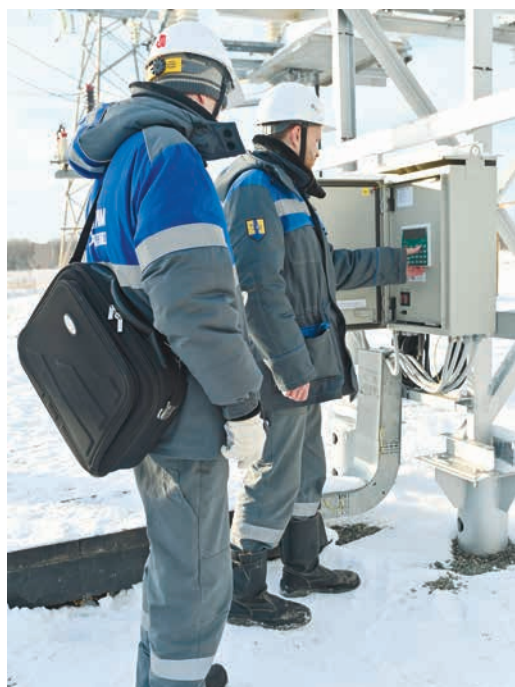
ПС «9 Января». Просмотр записи событий микропроцессорного устройства РЗА
