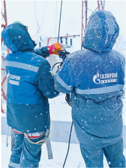
«ГП-7». Оттяжка гибкой шины для производства работ
