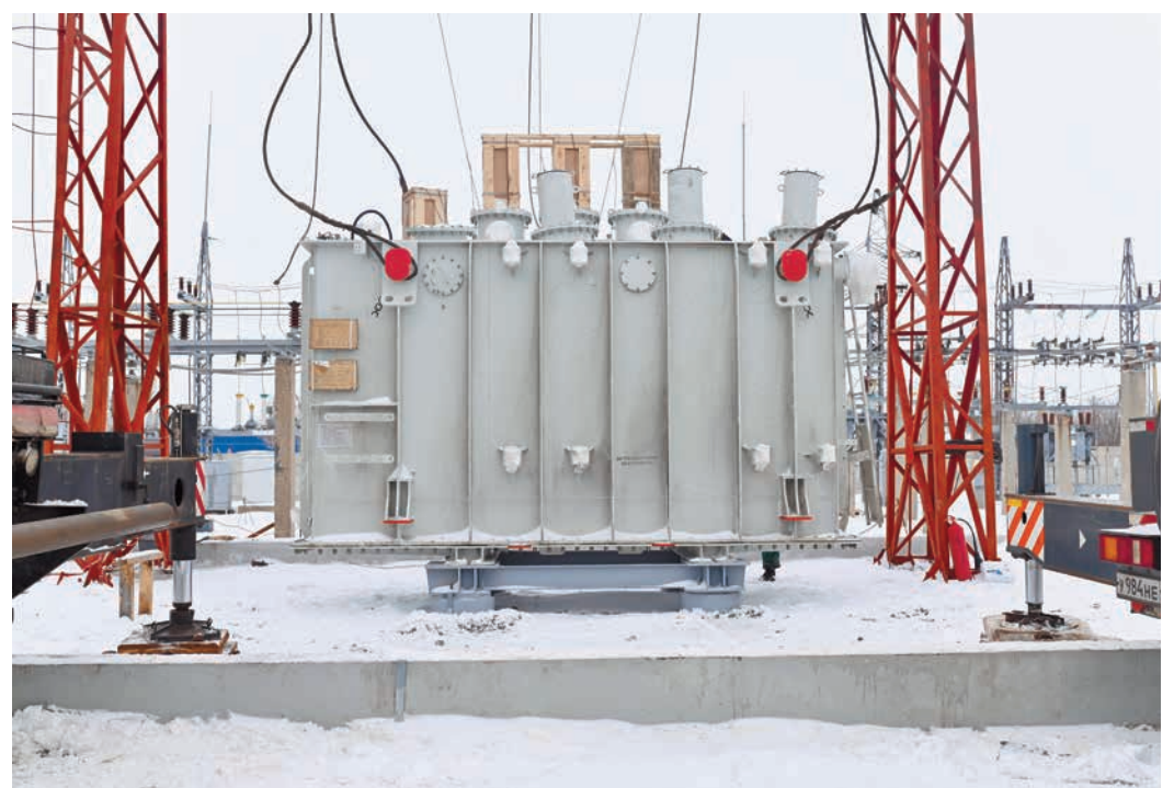
«ГП-7». Трансформатор установлен
