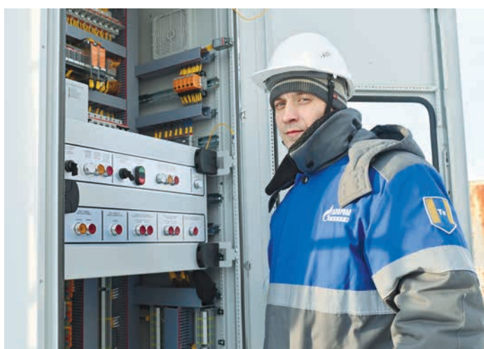
ПС «9 Января». Ведущий инженер ПЭТЛ СЭС Станислав Андреев на объекте
