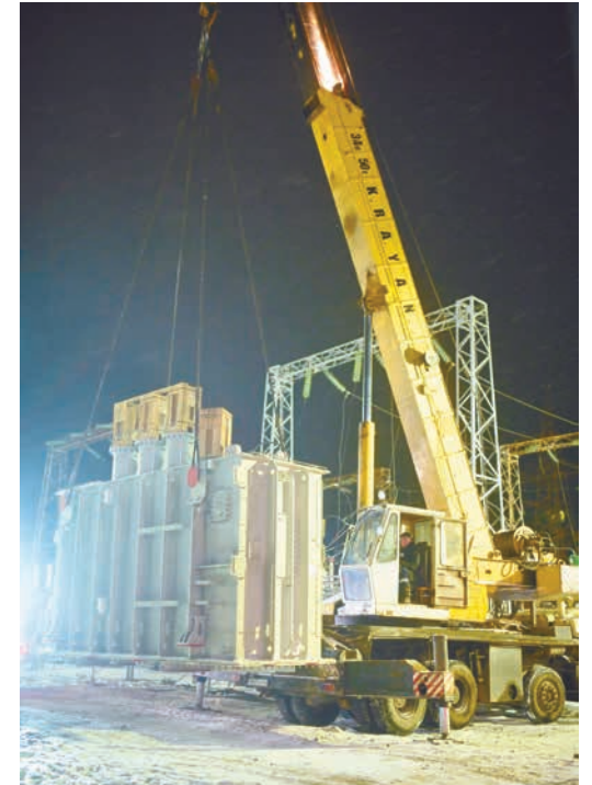
«ГП-7». Разгрузка трансформатора
