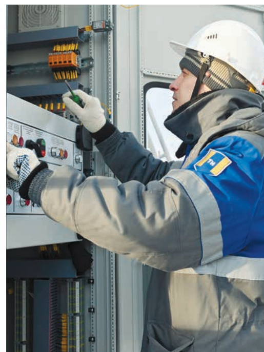
ПС «9 Января». Контроль монтажа вторичных цепей трансформатора
