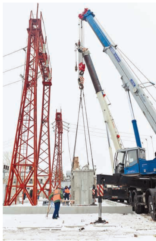
Установка трансформатора на ГПП-7
