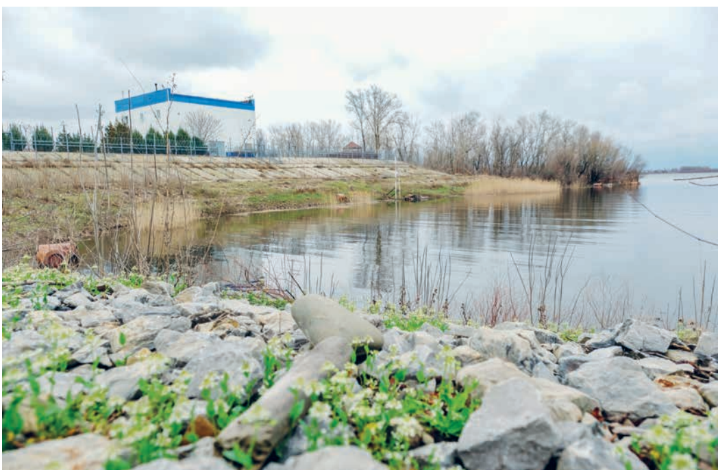
Водозабор на реке Бузан
