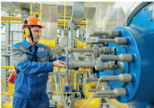
Безопасная эксплуатация котла
