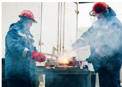
Электромонтеры производят спайку провода
