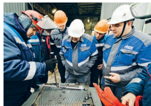
Результат сварки провода
