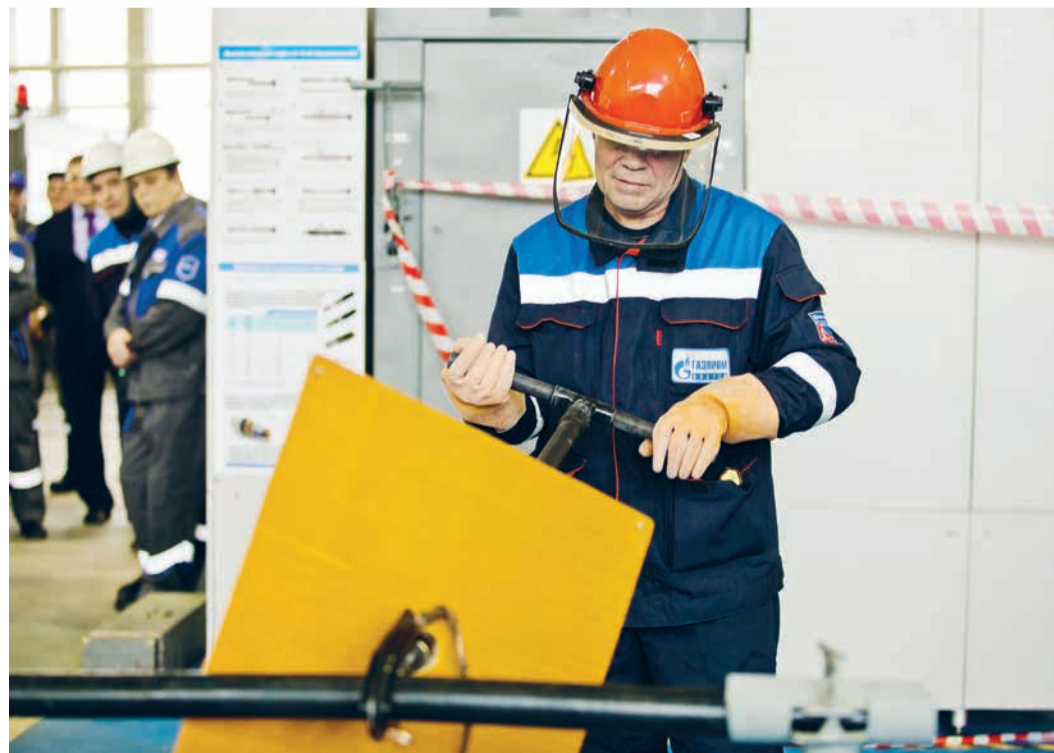
Проверка отсутствия напряжения на высоковольтном кабеле
