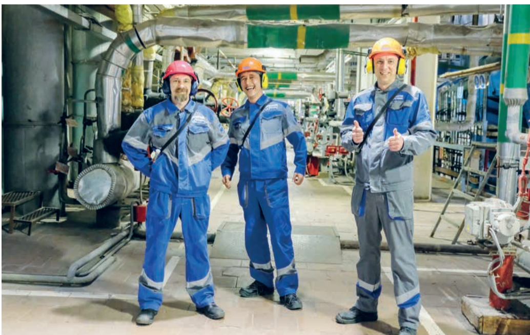
В главном корпусе пусковой котельной
