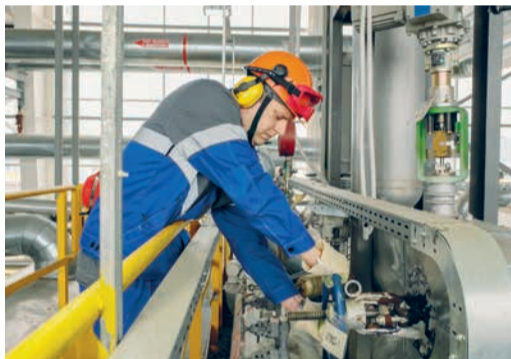
Закрывание опорной арматуры
